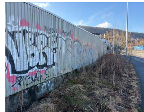
36. Lukket vegg mot BIR sin tidligere virksomhet i dag, langs Møllendalsveien.
