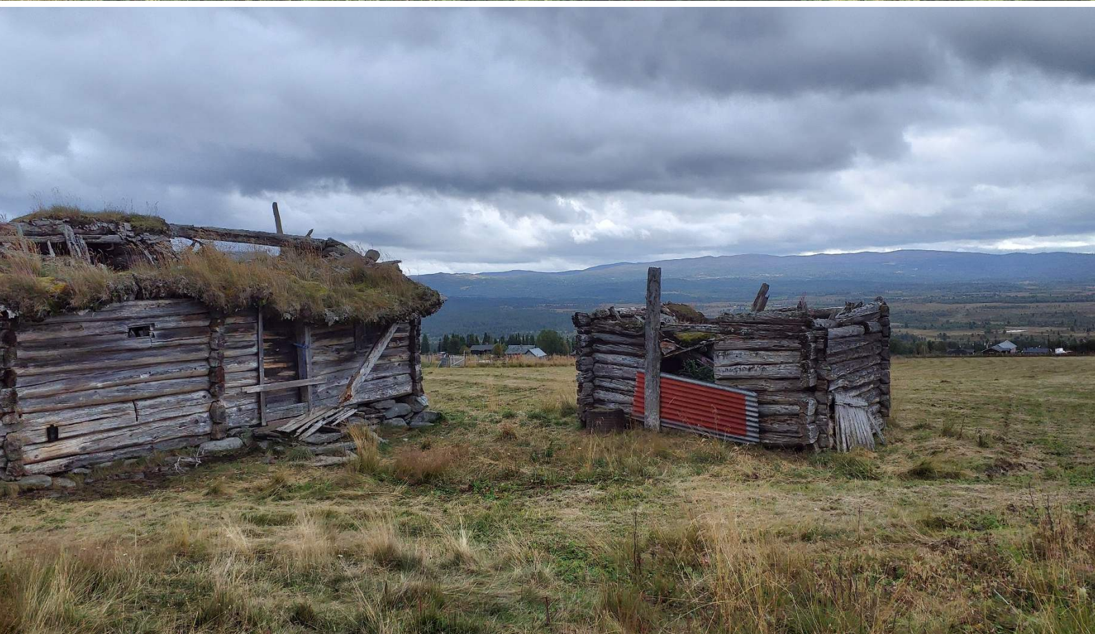
Figur 4-13: 39 av de registrerte bygningene i Nord-Aurdal er sterkt truet. «Mindre uthus i/nær tunet» og «Hus i utmark, seter» er de bygningskategoriene som er mest truet av forfall og tap. Øverst: En løe i Søre Smørleie. Foto: AH/Asplan Viak 2025. Nederst: Et sauehus på Fløten som står i fare for å gå tapt dersom det ikke gjøres forebyggende tiltak. Til venstre står en «sterkt truet» sel (157995936) Foto: IR/Asplan Viak 2025
