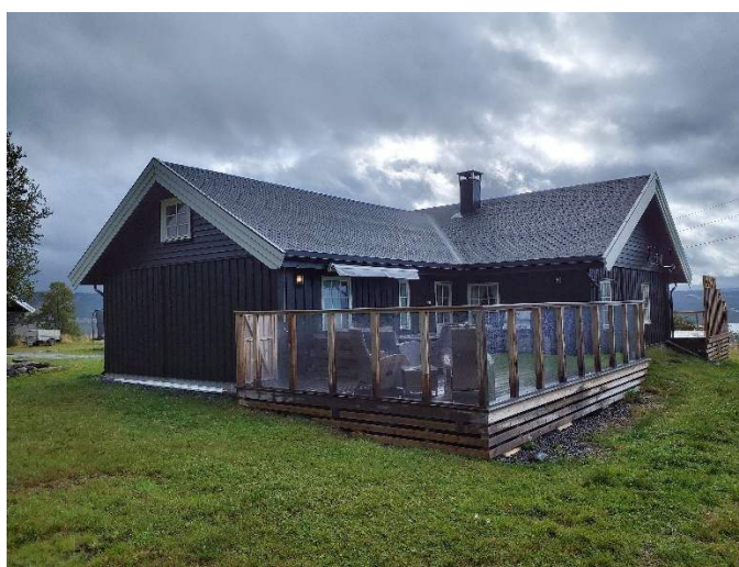
A - endring Eksempel på stor endring (A). Sel på Åberg, Åbjørstølen (140366870). Bygget har gjennomgått flere endringer siden det ble SEFRAK-registrert i 1978. Det har fått nytt tilbygg og veranda og tak, kledning og bla vinduer er skiftet ut Foto: IR/Asplan Viak, 2025
