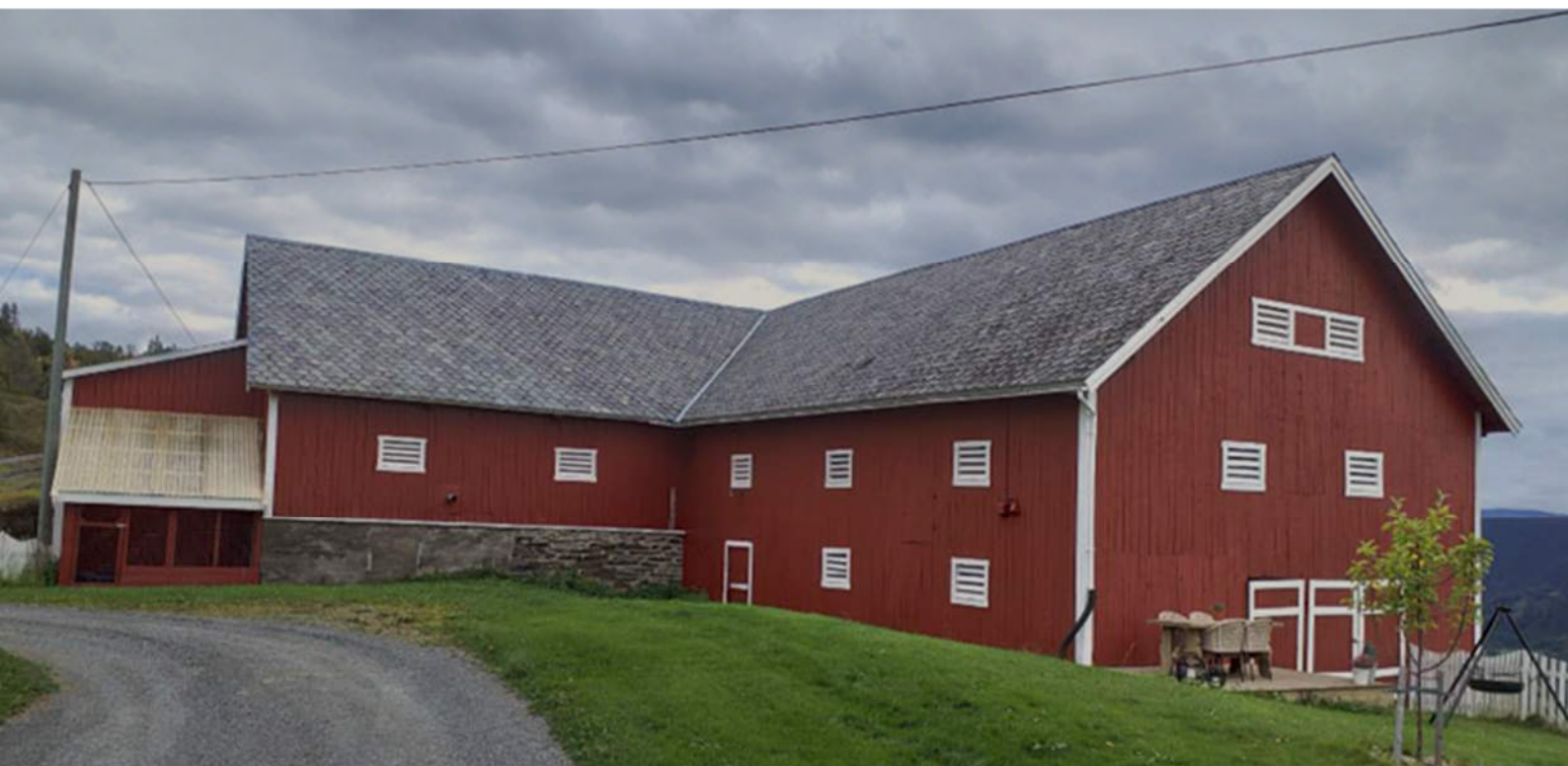
Figur 4-31: Enhetslåven samlet landbrukets behov innenfor fire vegger og rasjonaliserte driften på både småbruk og storgårder 38 . Bygningstypen ble vanlig etter det som gjerne omtales som det store hamskiftet omkring 1850. Flere funksjoner, som tidligere lå i hver sin bygning, ble samlet under samme tak: Låve for lagring av fôr, stall og fjøs med møkkjeller under. En låvebro gjorde det mulig å kjøre med hest og høylæss opp i loftsetasjen. Låven ble oppført i panelt bindingsverk, mens fjøset ble laftet eller oppført i tegl. Steinfjøset på Klettene i grunnkrets «Skrautvål» ble tilbygd med låve omkring 1934.
