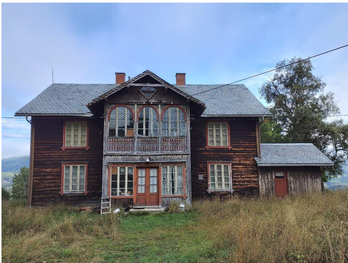
Figur 4-27 Hovedbygningen på Hove ble oppført i 1880-årene. Det ble drevet pensjonatvirksomhet her. Bygget fremstår autentisk, men med noe manglende vedlikehold. Foto: JO ASPLAN 2025 (5420022109)
