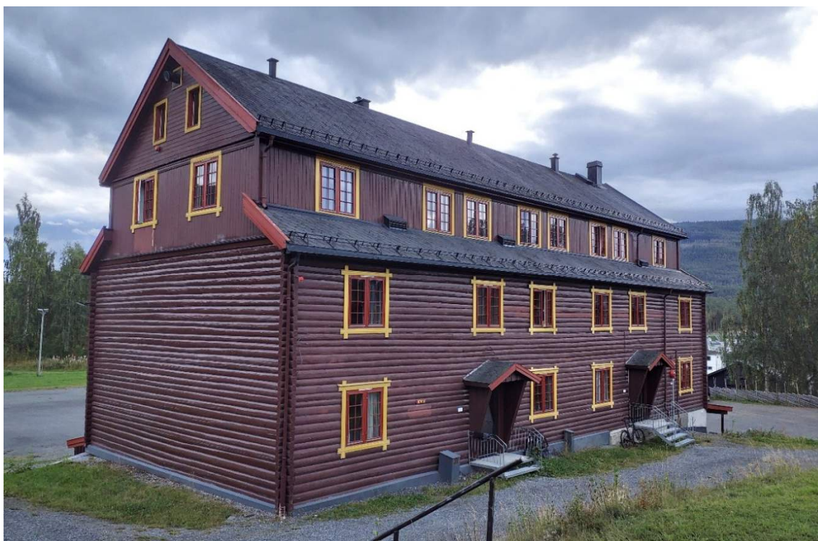
Figur 4-41 Skolebygningen «Jenteinternatet» på Valdres folkehøgskole, oppført omkring 1911, er et eksempel på en bygning i kategorien «andre bygningstyper». Bygningen ble lagt til i 5. omdrev, og er kommunalt listeført gjennom Temaplan for kulturminner i Nord-Aurdal, vedtatt i 2021. Akkumulert tap for kategorien «andre bygningstyper» er 11 %. Det gjenstår nå 24 av opprinnelig 27 SEFRAK-registrerte bygninger i denne kategorien. Foto: JOI/ASPLAN VIAK 2025 (5420016005).
