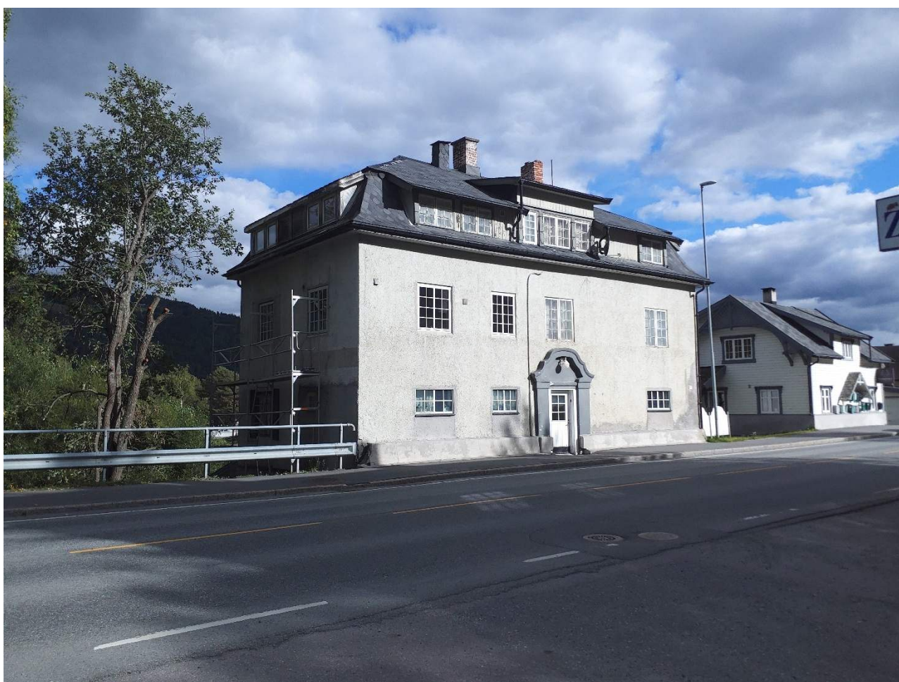
Figur 4-28 Det er registrert 3 bygårder i Nord-Aurdal kommune. Denne bygården kalt «Bjerknes» ligger ved Skarpsno like utenfor Fagernes sentrum i retning Valdresmuseet og skal være oppført på begynnelsen av 1900-tallet. Bygget ble lagt til i 5. omdrev da den står oppført i Temaplan for kulturminner i Nord-Aurdal fra 2021. Bygget ble kontrollregistrert for første gang nå i 6. omdrev. Bygget er vurdert til «intakt» og «uendret». Foto: AH/ASPLAN VIAK 2025 (BID 158050889)
