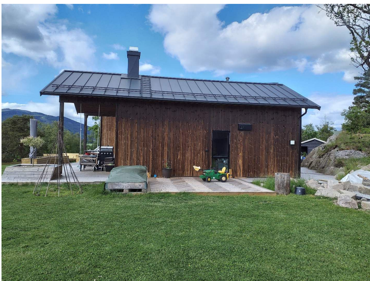
Figur 4-7 Eldre våningshus som var «intakt» i 4. omdrev har blitt revet og erstattet med nytt og moderne bolighus i 6. omdrev. Foto: AR/ ASPLAN VIAK 2025 (165705629).
