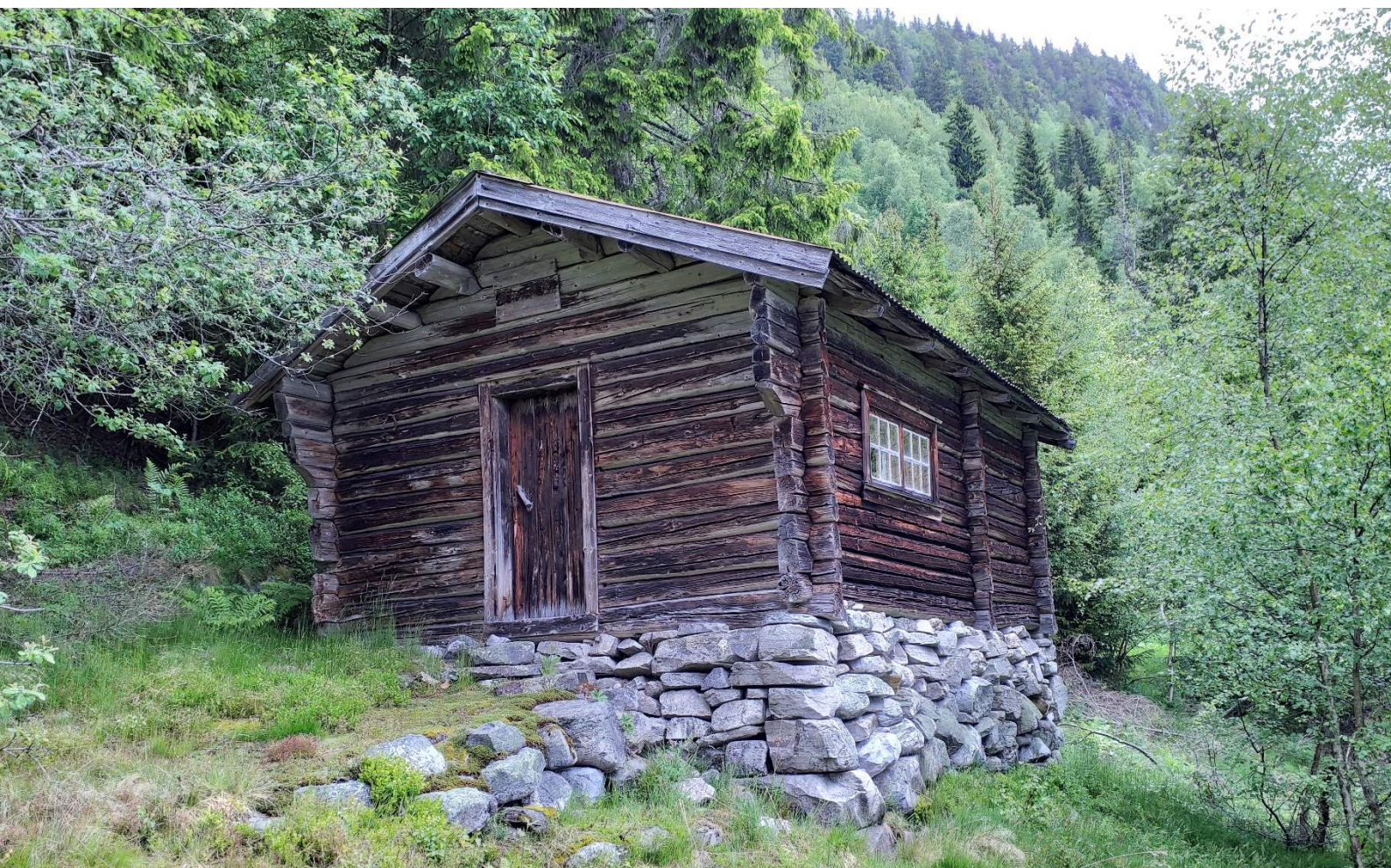
Figur 6-6 Seterbu fra tidlig 1800-tallet på Vårbu i grunnkrets «Folkestad 1». Foto: AR/Asplan Viak, 2025 (165699203)
