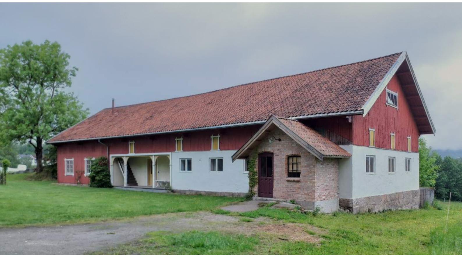
Figur 4-31: Enhetslåven samlet landbrukets behov innenfor fire vegger og rasjonaliserte driften på både småbruk og storgårder 38 . Bygningstypen ble vanlig etter det som gjerne omtales som det store hamskiftet omkring 1850. Flere funksjoner, som tidligere lå i hver sin bygning, ble samlet under samme tak: Låve for lagring av fôr, stall og fjøs med møkkjeller under. En låvebro gjorde det mulig å kjøre med hest og høylæss opp i loftetasjen. Låven ble oppført i panelt bindingsverk, mens fjøset ble laftet eller oppført i tegl 39 . Låven på Nordbø, ved Bø kirke, ble oppført omkring 1892.
