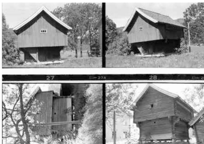
C - endring Dette stabburet på plassen Harpestå (165678214) har fått ny taktekkning siden bygget første gang ble registrert i SEFRAK i 1987. Utskifting av taktekkning er en mindre endring (C). Foto: AH/Asplan Viak, 2025
