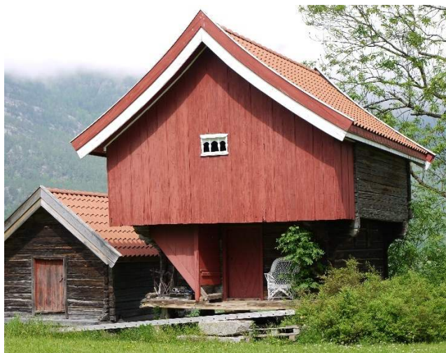
C - endring Dette stabburet på plassen Harpestå (165678214) har fått ny taktekkning siden bygget første gang ble registrert i SEFRAK i 1987. Utskifting av taktekkning er en mindre endring (C). Foto: AH/Asplan Viak, 2025
