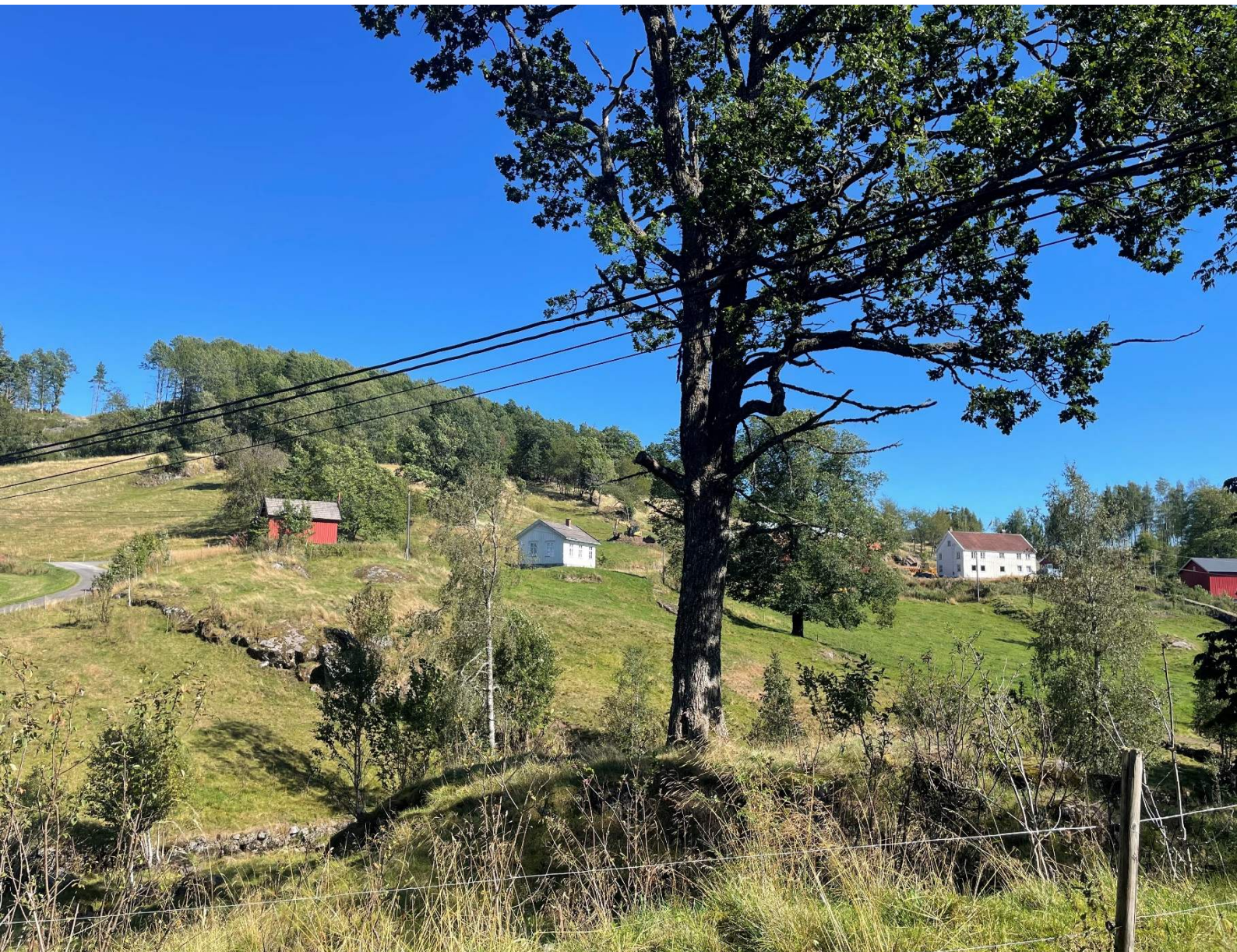
Figur 3-2 Oversiktsbilde fra grenda Vestøl, nordvest for Gjerstad sentrum. På bildet vises Vestøl skole/grendehus (167480470) midt i bildet, samt innhuset (167480454) på plassen «Der Framme» til høyre. Sistnevnte bygg var under restaurering ved registrering- Vestøl er omfattet av hensynssone for bevaring av kulturmiljø i kommuneplanens arealdel. Foto: AH/ASPLAN VIAK 2025
