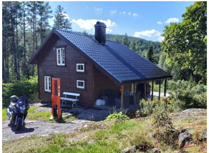
A - endring Eksempel på stor endring (A). «Stauhus,» Skorva, Ljødal i Gjerstad (9110207030). Bygget har gjennomgått flere endringer siden det ble SEFRAK-registrert i 1993. Huset har fått nytt og utvidet tak, nye vinduer, nytt panel og terrasse. Foto: AH/Asplan Viak, 2025
