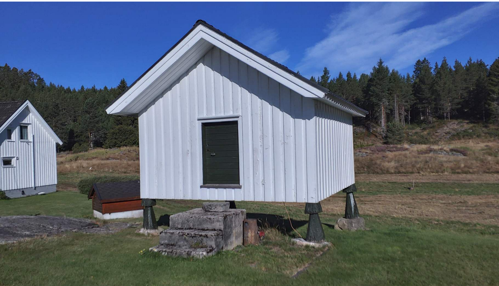
Figur 4-33. Stabbur/loft faller inn under kategorien «mindre uthus i/nær tunet». Kategorien omfatter sidebygninger, stabbur/loft, smier, uthus knyttet til boliger/bygård og andre mindre uthus. Akkumulert tap i 1.-6. omdrev for mindre uthus i/nær tunet er 24 % i Gjerstad. 30 av opprinnelig 131SEFRAK-registrerte bygg i denne kategorien har gått tapt siden de ble registrert på tidlig 1990-tallet. I 6. omdrev ble 20 SEFRAK-registrerte stabbur og loft kontrollregistrert. Stolpehuset på Skorstøl, Fiane er egentlig et gammelt fjøs ombygd til stabbur. Det ble flyttet hit fra Vegårdshei en gang sent på 1800- eller tidlig på 1900-tallet Foto: AH/ASPLAN VIAK 2025 (9110101033).
