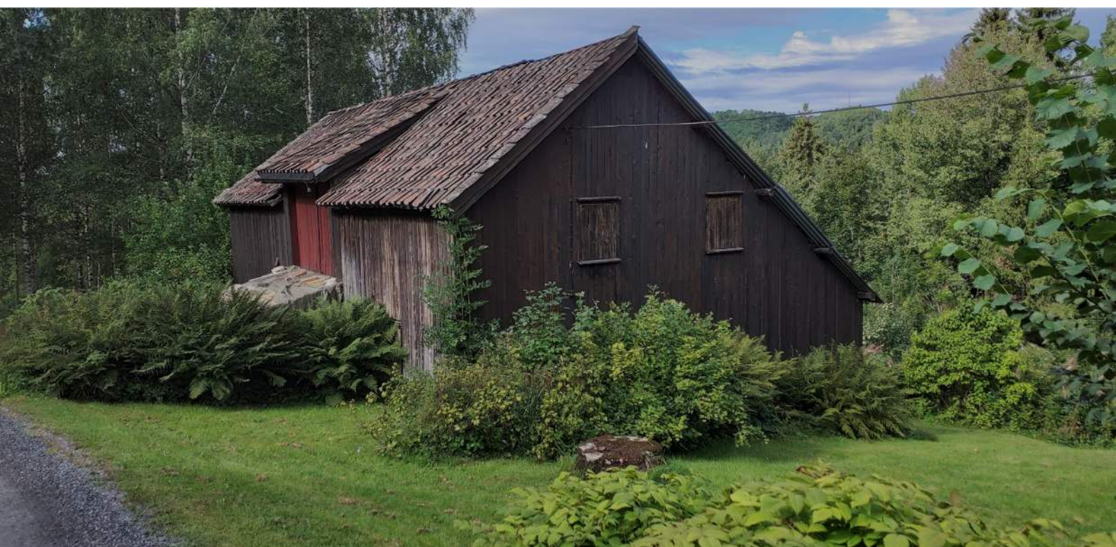
Figur 4-30: Enhetslåven samlet landbrukets behov innenfor fire vegger og rasjonaliserte driften på både småbruk og storgårder 36 . Bygningstypen ble vanlig etter det som gjerne omtales som det store hamskiftet omkring 1850. Flere funksjoner, som tidligere lå i hver sin bygning, ble samlet under samme tak: Låve for lagring av fôr, stall og fjøs med møkkjeller under. En låvebro gjorde det mulig å kjøre med hest og høylæss opp i loftsetasjen. Låven ble oppført i panelt bindingsverk, mens fjøset ble laftet eller oppført i tegl. Denne låven på Kveim i Øvre Gjerstad er trolig oppført på 1850-tallet.
