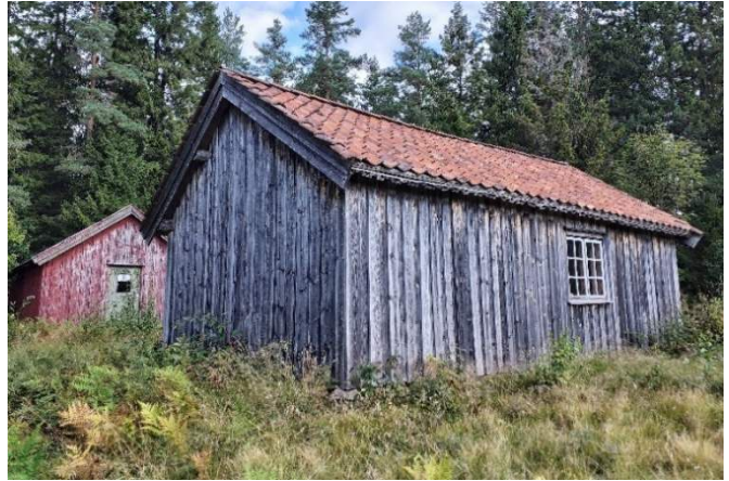
C - endring Denne seterbua (9110203017) på Åsland, Øvre Gjerstad har fått ny takteking og nytt/istandsatt panel siden den første gang ble registrert i SEFRAK i 1991. Denne typen endringer defineres som en mindre endring (C). Foto: AH/Asplan Viak, 2025
