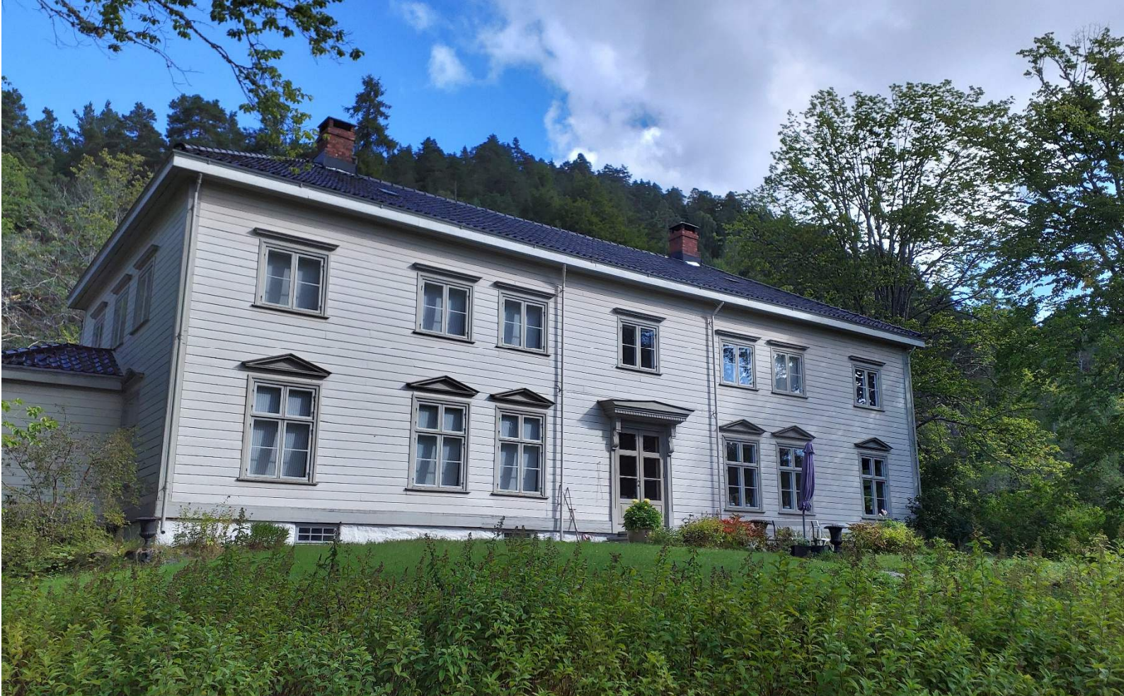
Figur 6-2 «Den nye forvalterboligen» på Eikelands verk ble oppført i 1830-årene (9110102032). Bygningen ble oppført i bindingsverk innfelt med stående tømmer og slaggstein. Utvendig hadde huset opprinnelig pusset/rapet overflate, men etter kort tid fikk den liggende panel. Bygningen er oppført i senempirestil med valmtak med glaserte tegl, tympanonfelter over vinduer og dører i 1. etasje. Mellom 1912 og 1927 huset bygningen en husmorskole. Bygningen er del av Eikelandsverk som er vedtaksfredet i flere omganger, første gang i 1923, og med supplerende utvalg bygninger i 2017. Foto: MMS/ASPLAN VIAK 2025
