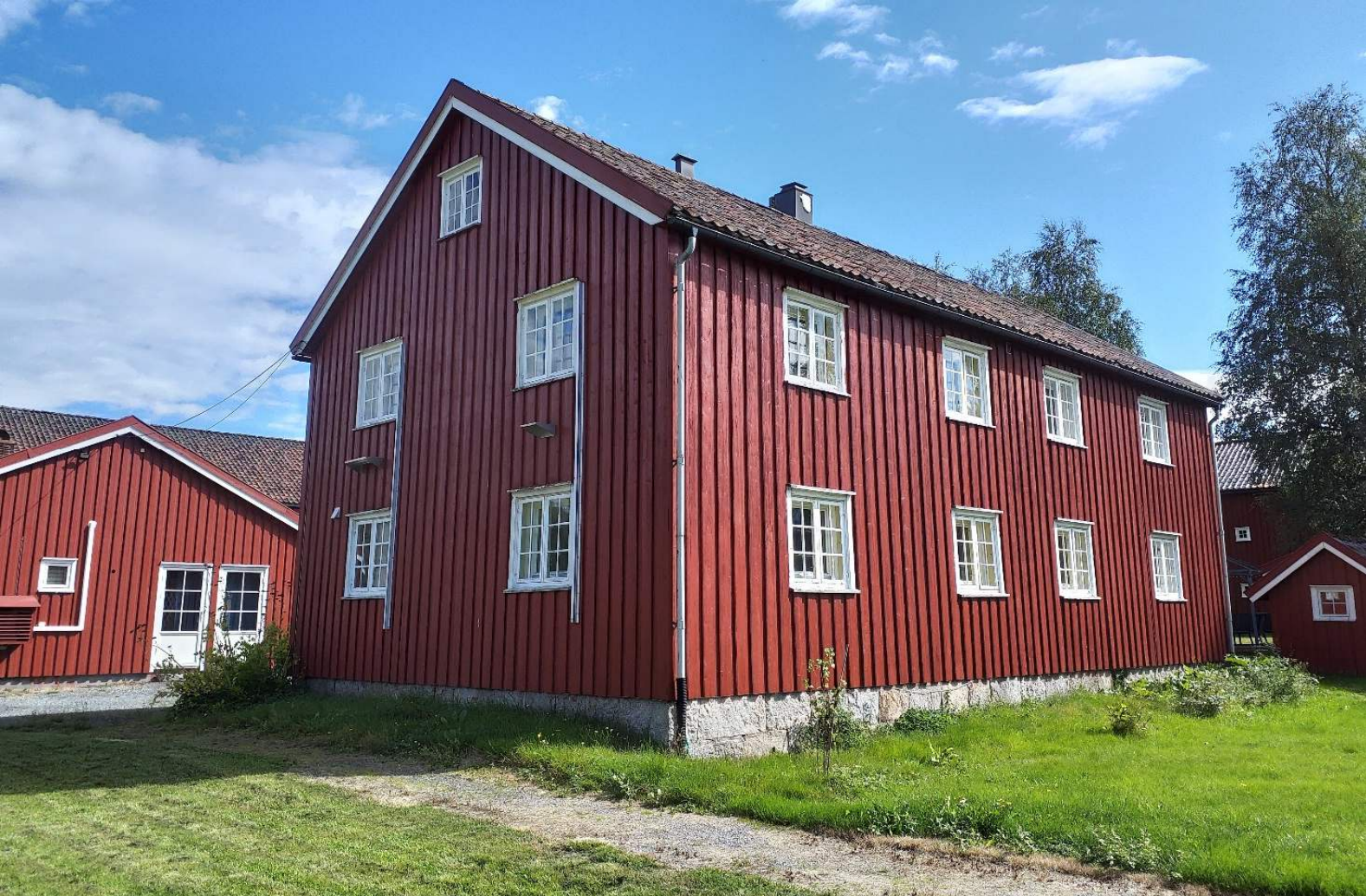
Figur 6-3 Forpakterboligen på Holmen gård. Fire av bygningene på Holmen gård er vedtaksfredet. Gårdsanlegget ligger også innenfor Hensynssone H570 – bevaring kulturmiljø i gjeldende kommuneplan. Foto: MMS/ Asplan Viak 2025
