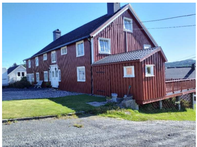
B - endring Et eksempel på en middels volumendring (B). Etter at våningshuset på Brokeland, Fiane (9110103001) ble SEFRAK-registrert i 1985 har den bl.a. fått ny takteking, pipebeslag, terrasse og utebod. Foto: MMS/Asplan Viak, 2025
