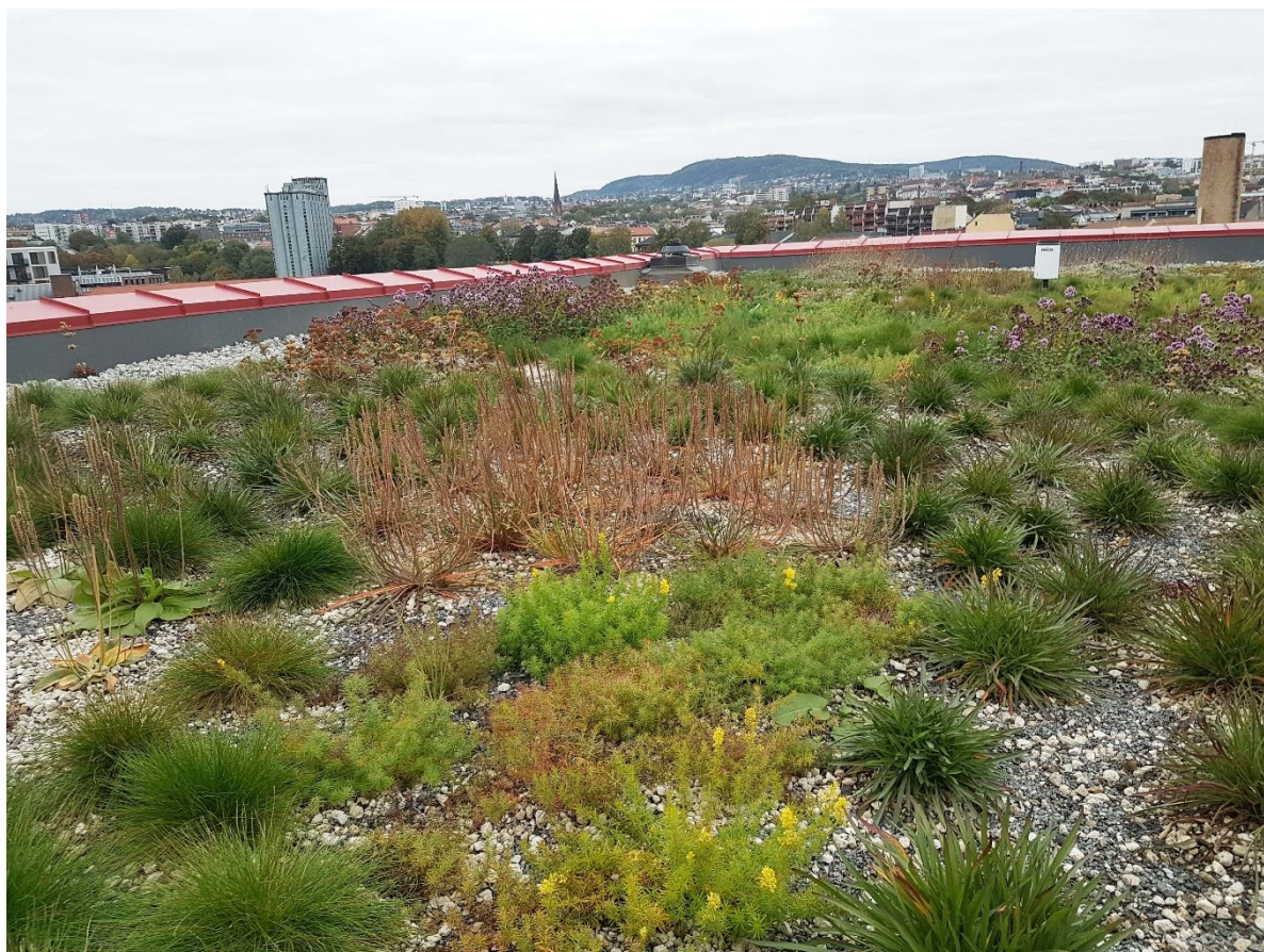
Figur 21. Oversiktsbilde fra august 2019. Her ses tydelig planting i grupper og mye eksponert vekstmedium mellom plantene, foto: NIBIO, Hans Martin Hanslin
