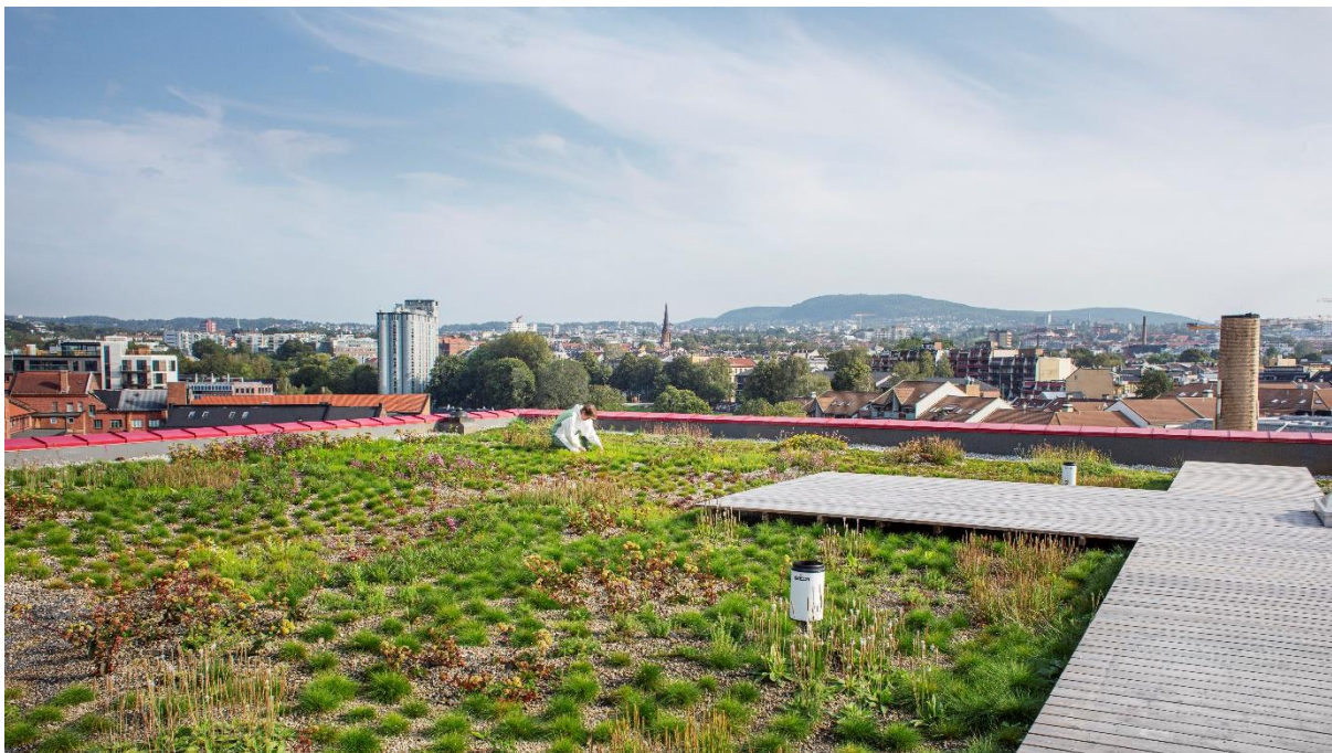
Figur 20 Vegetasjonen ble etablert i juni 2019, bildet er fra august samme år, foto: Asplan Viak, Åse Holte
