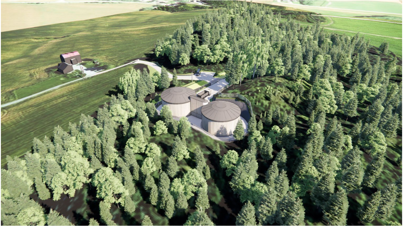
Figur 4-3 Høydebassenget sett fra sørvest – sirkulære bassenger
