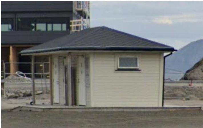
Eksisterende servicebygg på eiendom Gnr.18 Bnr. 2303
