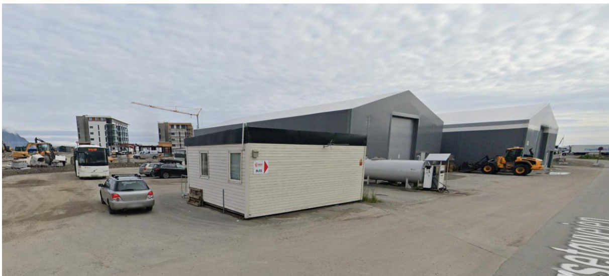
Eksisterende lagerbygg på eiendom Gnr.18 Bnr. 2255
