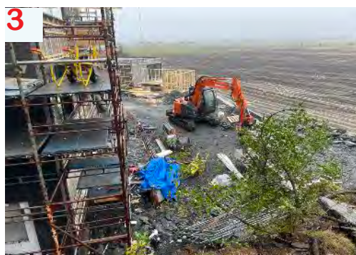
3 Vest for tomte - under bygging. Utsikt mot nordvest.
