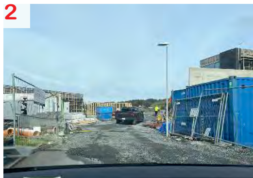
2 Mulig adkomstvei vest for tomte - under bygging
