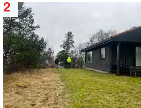
Eksisterende bolig med planert hageareal
