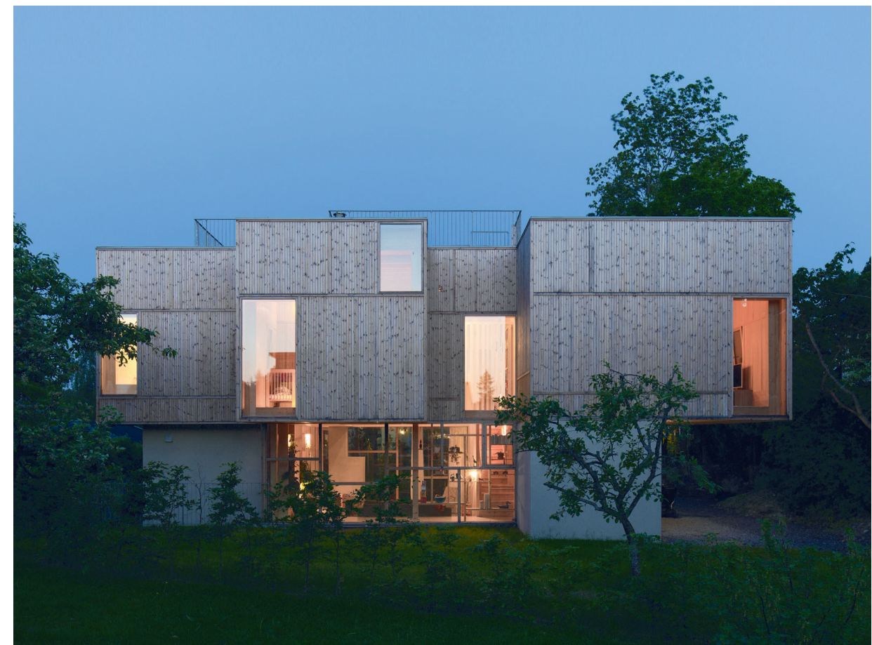
Referanseprosjekt: Enebolig Holtet, Oslo - Atelier Oslo
