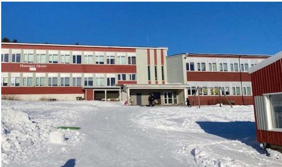
Bilde fra befarings 12.03.25, skolegård sett mot nord
