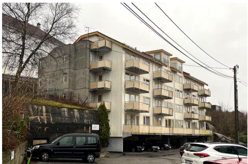
Bilde 6 Eksempel på større leilighetsbygg i nærområdet: Stadionveien 19A. Foto: Asplan Viak, 25.02.2025
