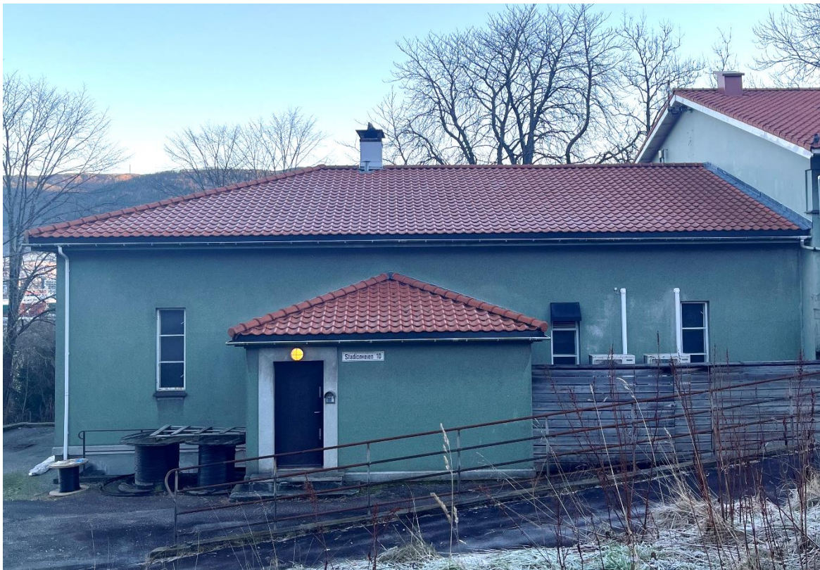
Figur 4-5. Stadionveien 10, opprinnelig bygg, fasade mot vest
