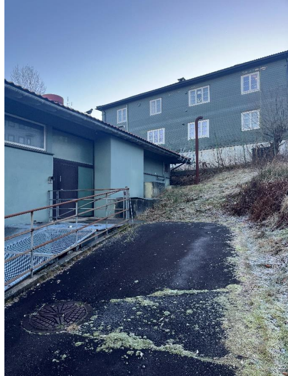
Figur 4-18. Tilbygg, vestre fasade. «Speiderhuset» i bakkant
