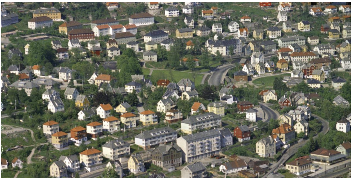
Figure 5-2. Automatsentralen i 1963, her i et utvidet fugleperspektiv. Byggets arkitektoniske kvaliteter kan sees i sammenheng med nyere bygg fra mellomkrigs- og etterkrigstiden med tilsvarende kvaliteter, slik som valmet tak og pusset fasade. (kilde: Marcus/UiB)
