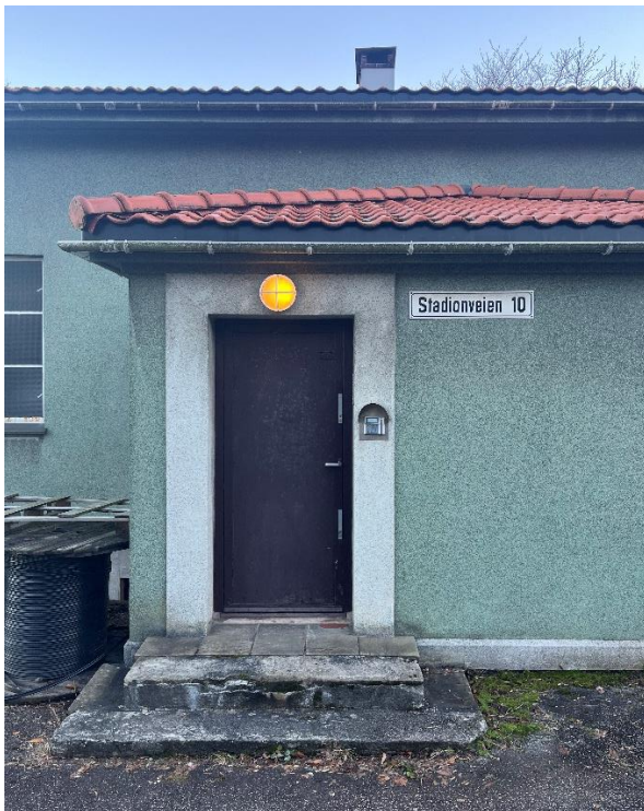
Figur 4-7. Hovedinngang i det opprinnelige bygget
