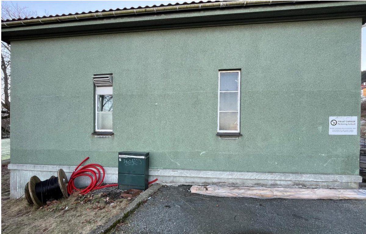
Figur 4-6. Stadionveien 10, opprinnelig bygg, fasade mot nord
