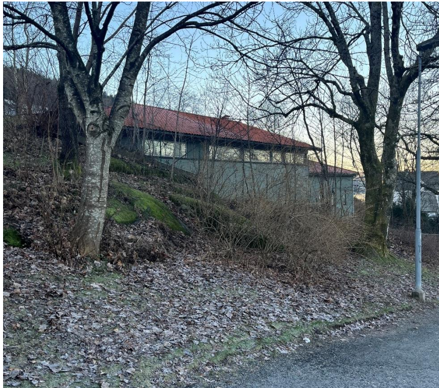
Figur 4-22. Tilbygg med opprinnelig bygg i bakkant, østre fasade. Bilde er tatt fra stien opp mot Damsgård
