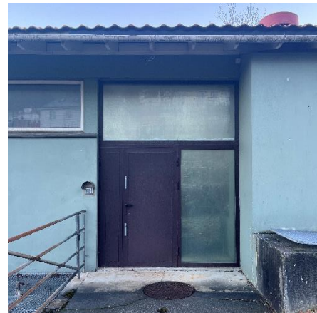
Figur 4-16. Tilbygg, øvre inngang i vestre fasade
