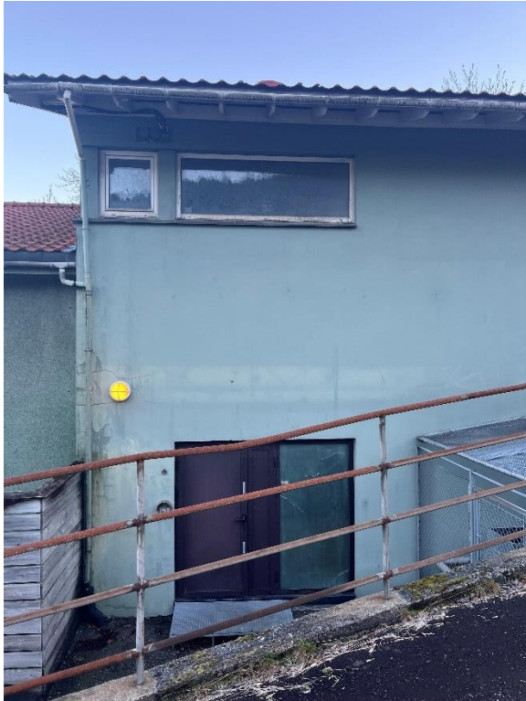
Figur 4-17. Tilbygg og nedre inngang i vestre fasade
