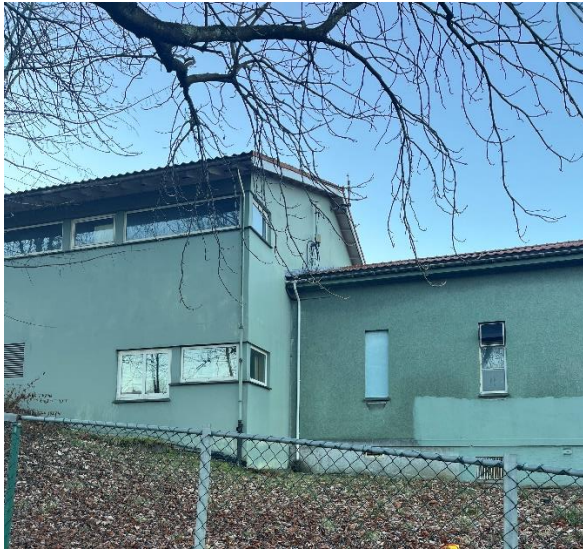
Figur 4-13. Overgangen mellom opprinnelig bygg og tilbygg. Fasade mot øst
