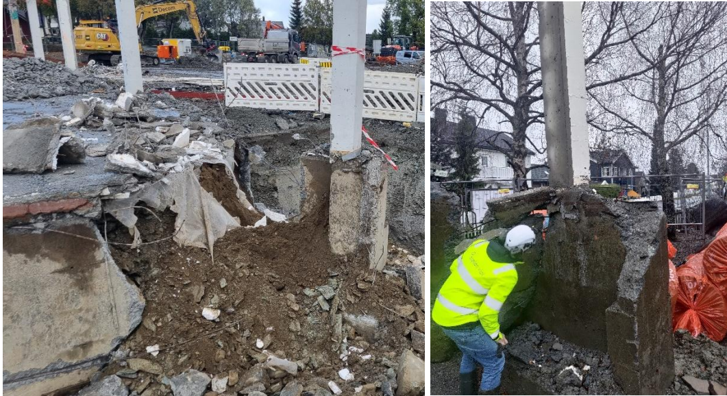
Figur 8 - Søyلة etter adskillelse fra fundamentveggen, og inspeksjon etter løfting og flytting til lagring på byggeplassen.
