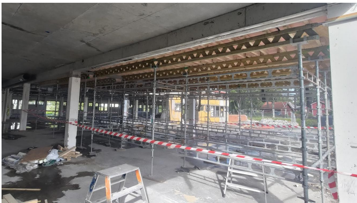
Figur 12 - Stillaset under betongen som ble skåret ut.
